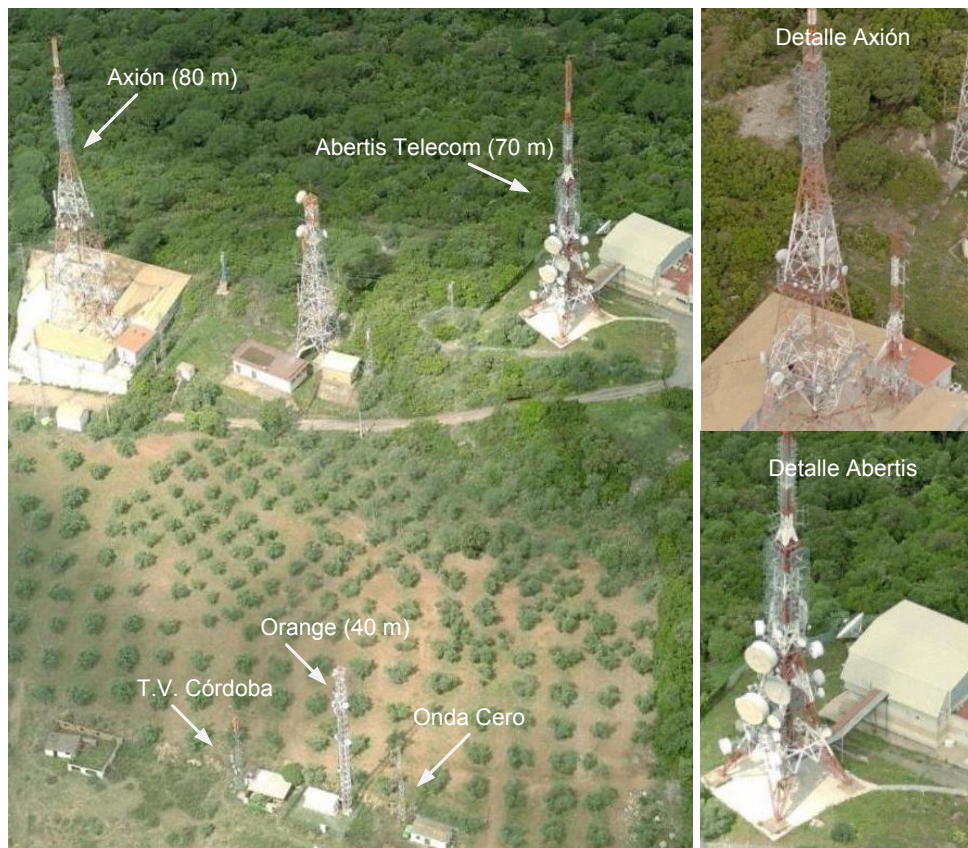
Figura 8. Panorámica de las torres existentes en el cerro de San Cristóbal.
