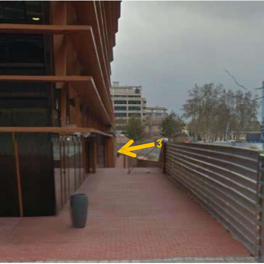
Fig. 5 Lateral derecho de las instalaciones
