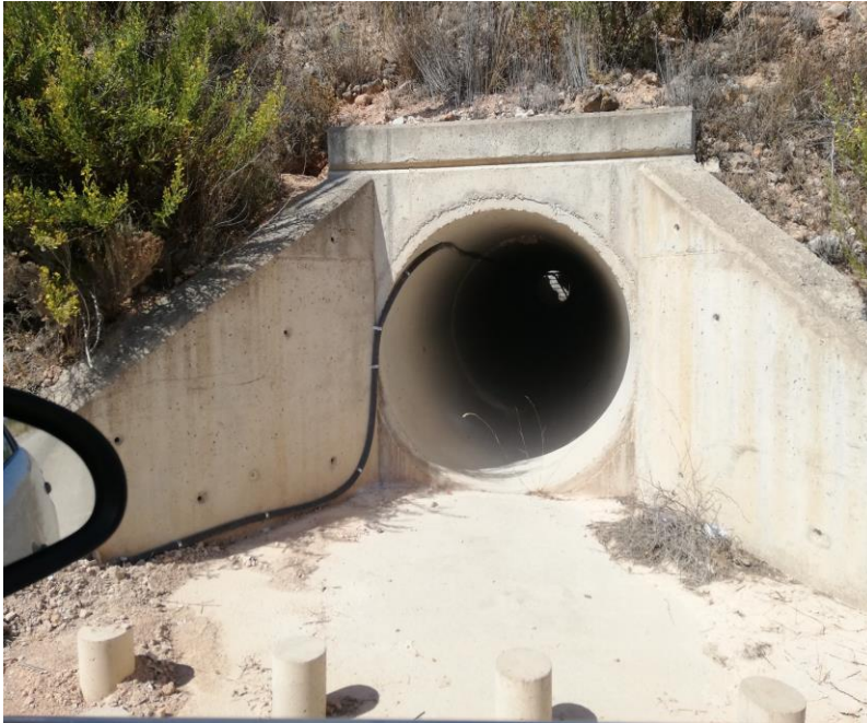
Figura 2 – Drenaje transversal bajo calzada y cable de fibra
